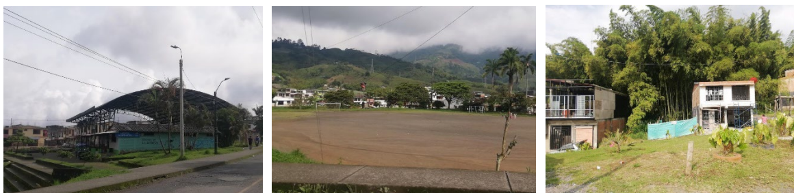
Fotografía 34. Imagen 36. Estado del Espacio Público.
